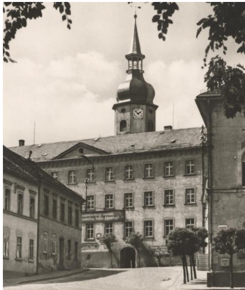
Das Schulgebäude von 1858, Foto aus DDR-Zeit („Polytechnische Oberschule“).
